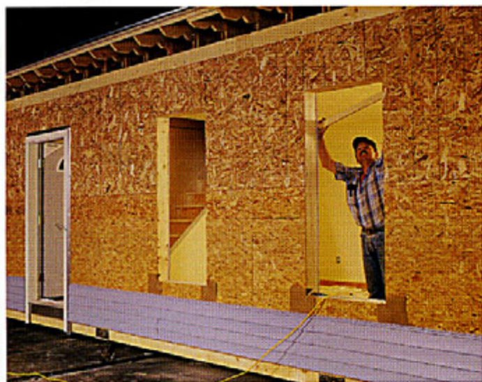
OSB Platten in Übergröße sind erhältlich – bis zu 2440 mm x 7320 mm.
